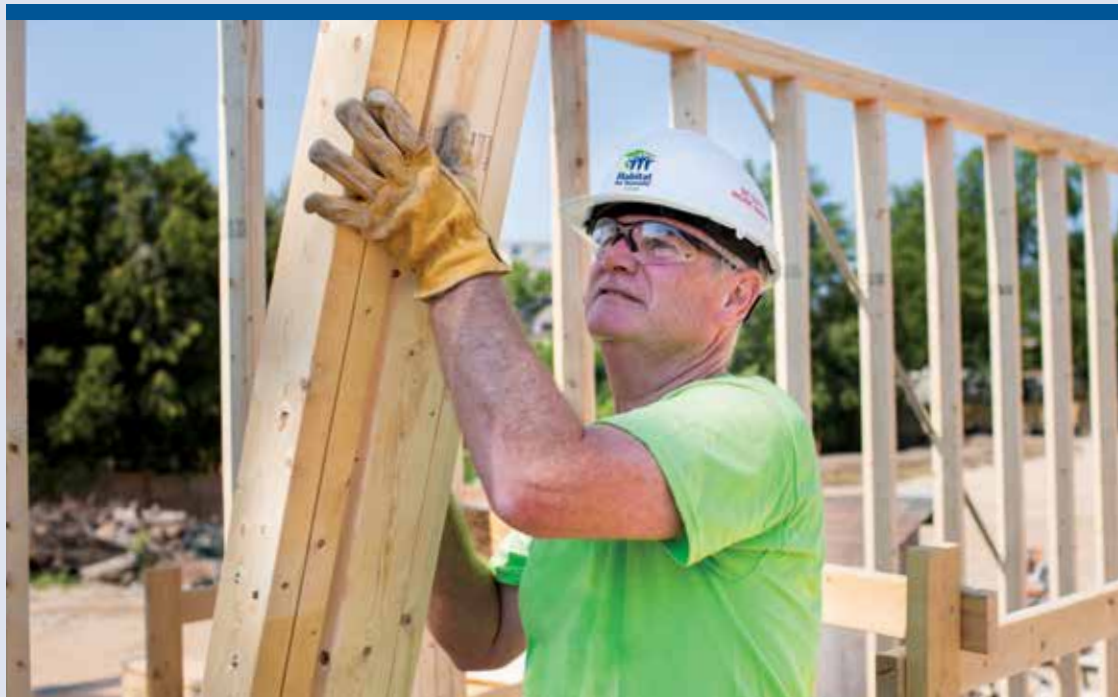
Kevin aide à lever les murs pour la maison d'une famille Habitat de Waterloo, en Ontario.
