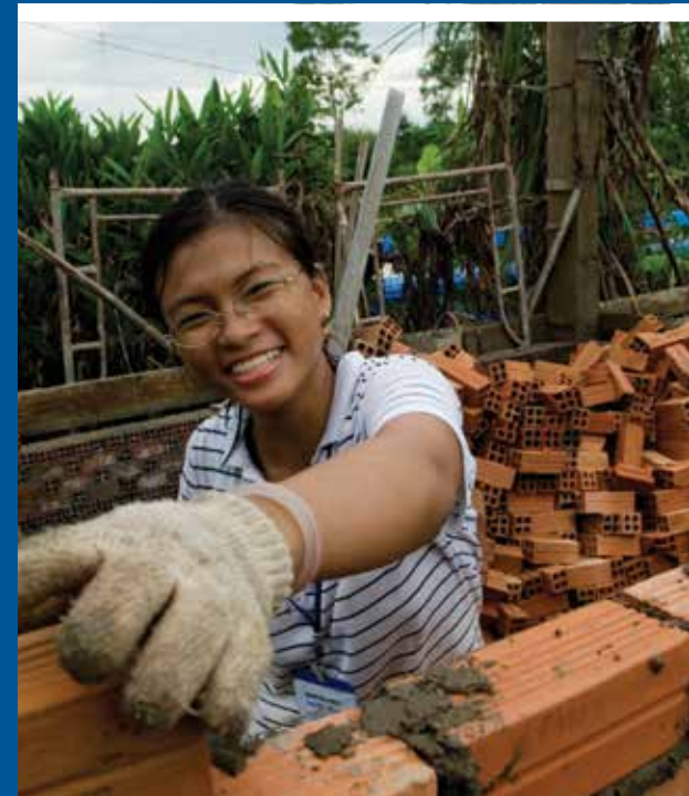
Une bénévole canadienne travaille à la construction des murs d'une maison pour une famille au Vietnam.
