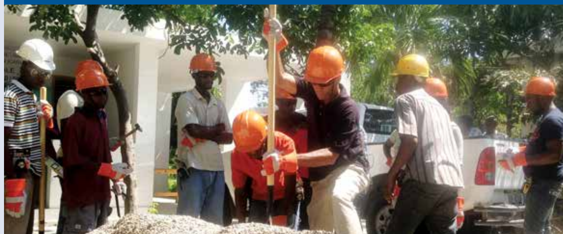
Formation en construction à Simon-Pelé, en Haïti, dans le cadre du deuxième projet de développement d'Habitat pour l'humanité Canada en partenariat avec Affaires étrangères, Commerce et Développement Canada.
