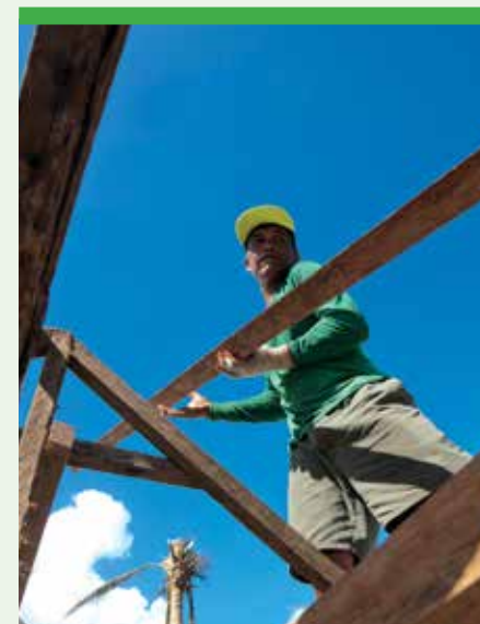
Michael Lacay répare sa maison à l'aide de matériel de construction qu'il a reçu dans la trousse d'abri distribuée par Habitat.
